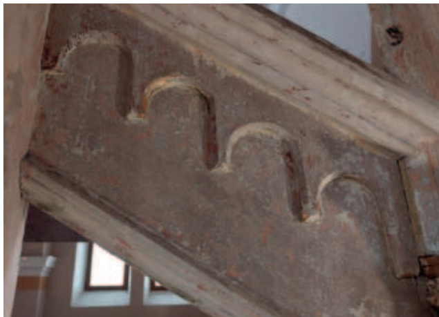
Fot. 26 i 27. Oczyszczone miejsca ze starych farb i złoteń (fot. Ewa Szydłowska)
