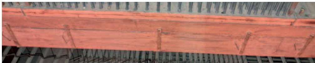
Fot. 18. Pokrywy wiatrownicy wraz z zaczepami
