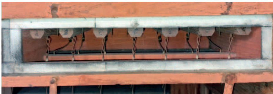
Fot. 14. Zbliżenie na kłapy
