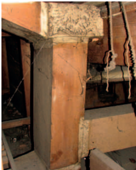
Fot. 10. Kanały powietrza (fot. autor)
