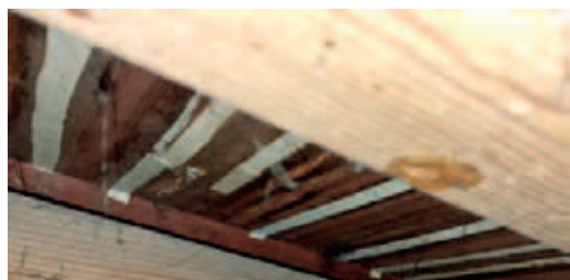
Fot. 8. Spód wiatrownicy z widocznymi uszczelnieniami
