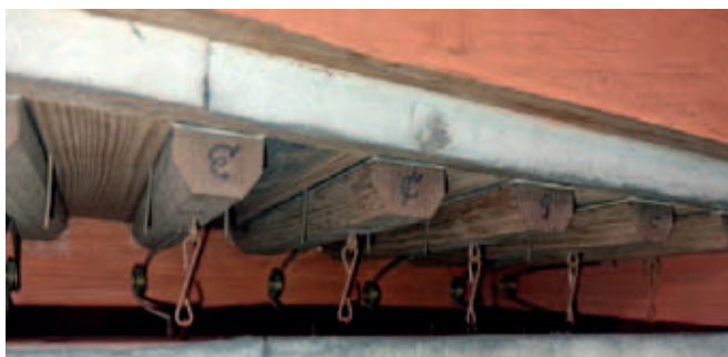
Fot. 15. Zbliżenie na inskrypcje widoczne na kłapach
