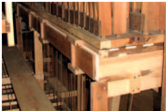
Fot. 31. Wiatrownica pedału z piszczałkami, widoczne wstawki nowego drewna (fot. autor)
