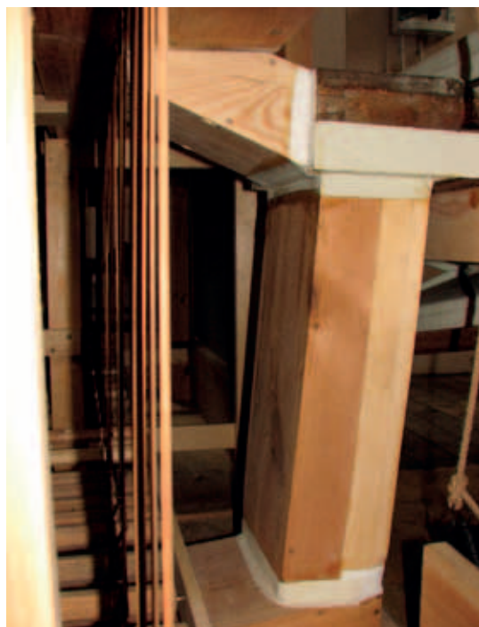
Fot. 32. Naprawiony kanał powietrza (fot. autor)
