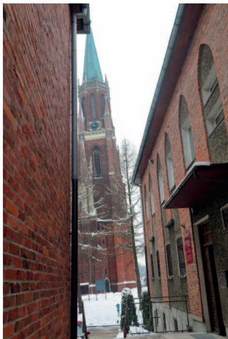
Fot. 4. Widok nachylenia kościoła względem innych budynków
