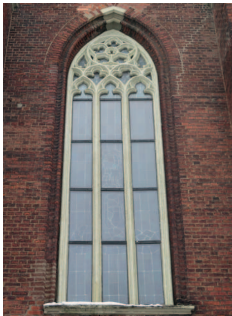
Fot. 3. Okno boczne z maswerkem
