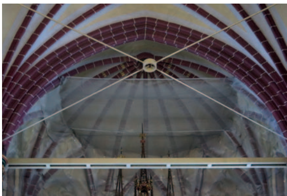
Fot. 6. Ankry i zabezpieczenie sufitu
